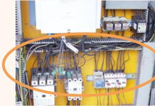
reduzierte Anzahl von Anschlüssen (weniger Stromversorgungsklemmen)
