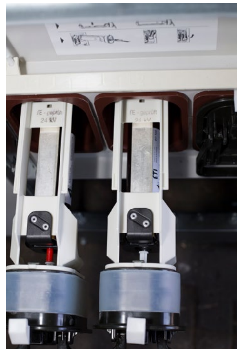
Beispiel: Anschluss in einer Innenraumschaltanlage
